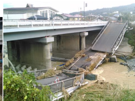
丸子地域：内村橋（歩道橋）
