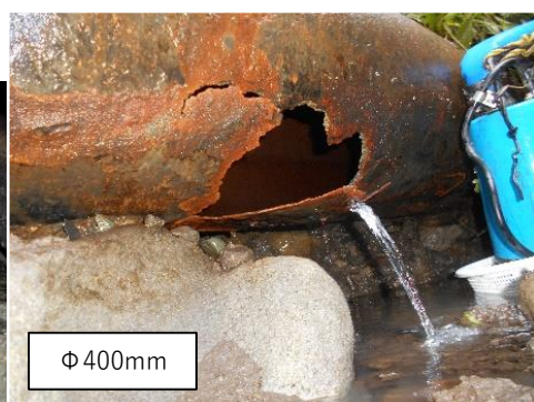
管破断状況
