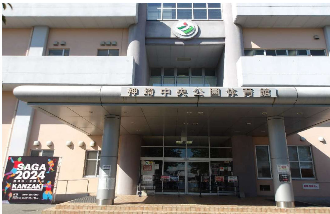
神埼中央公園体育館 正面
