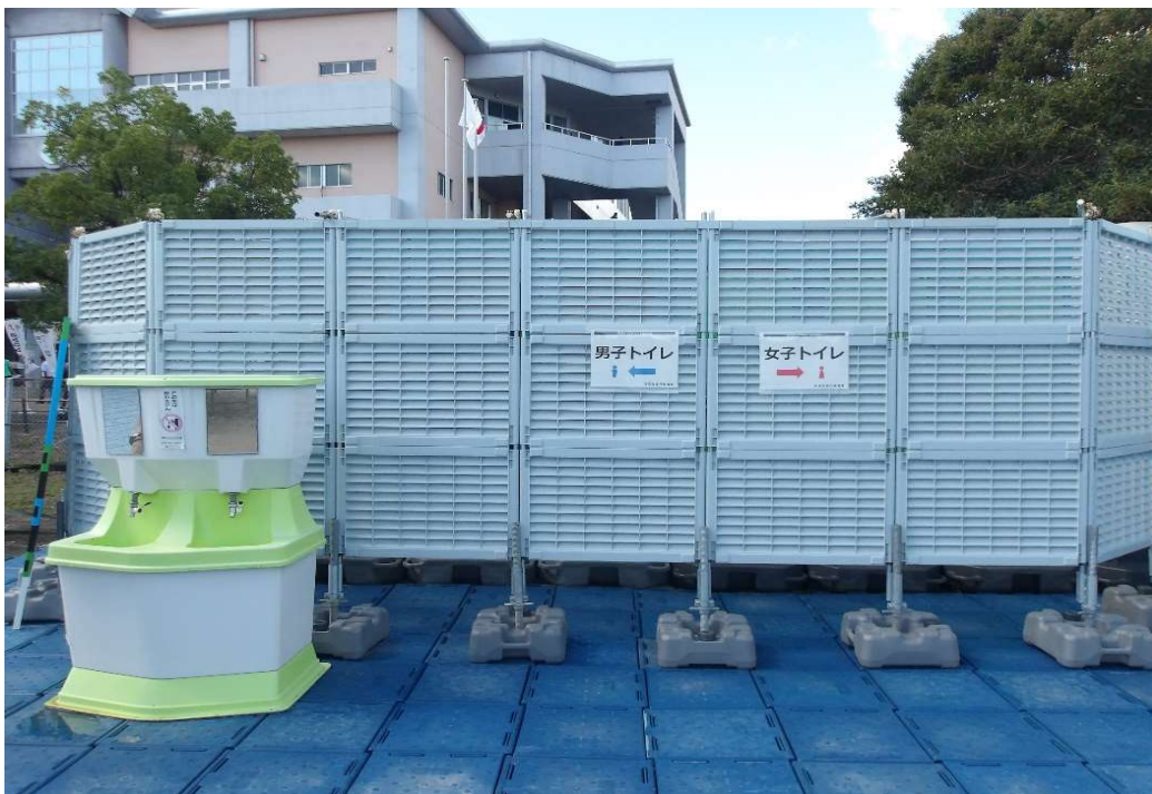
駐車場の仮設トイレ
