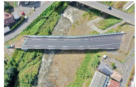
写真は神川橋上部工事完成直後の様子です。
