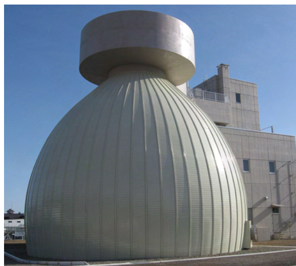
上田市下水浄化センターのメタン発酵設備(資料:上田市)
