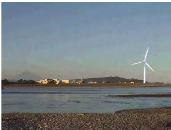
大型(1,500kW)風車の例 (資料:静岡県静岡市)
