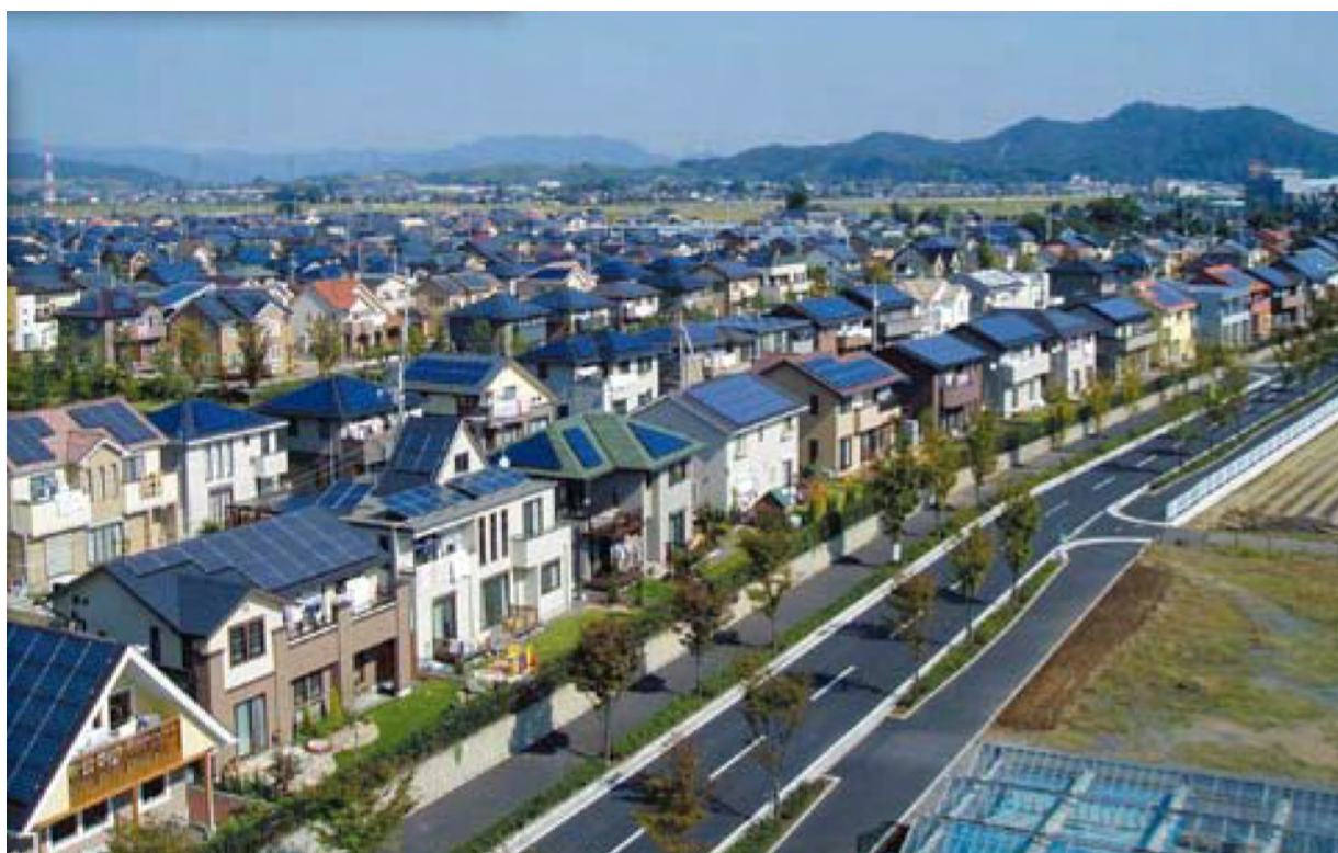
群馬県太田市「PalTown 城西の杜」(資料:NEDO 技術開発機構)
