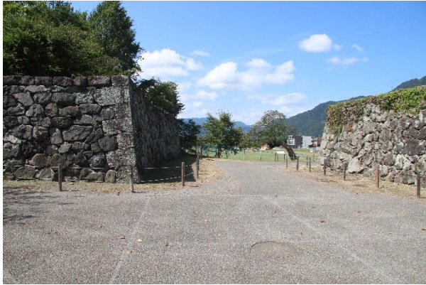
写真 23 二の丸北虎口 東から
