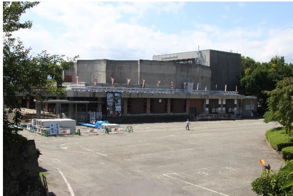
写真 25 二の丸南東側 北東から
