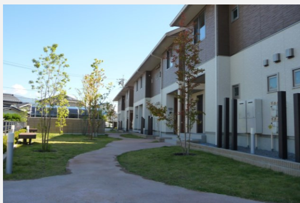
積和不動産中部(株)アパート新築工事（上田原）_平成25年度受賞
