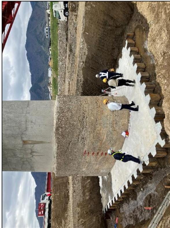
基礎を拡幅し河床低下時の安定性を確保する
