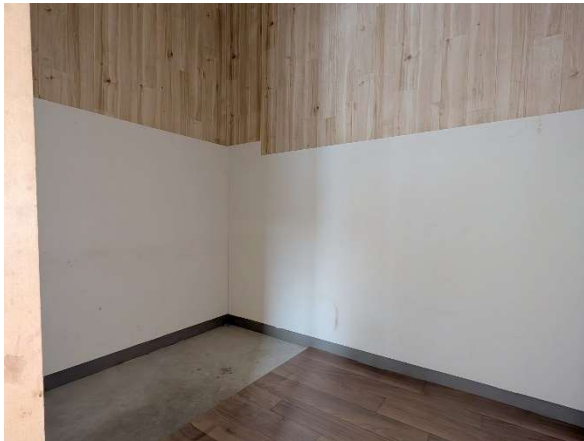
休憩室（旧倉庫）
