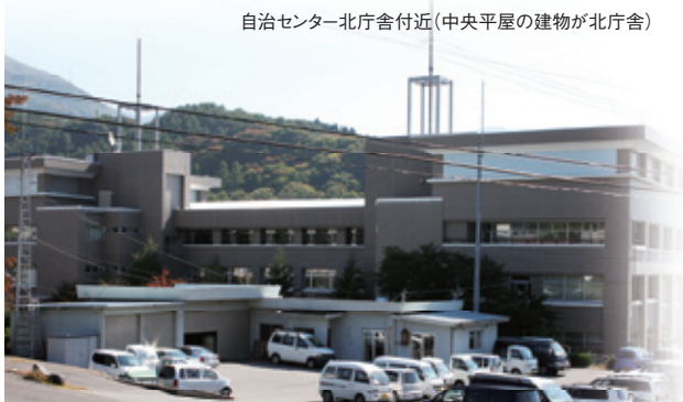
自治センター北庁舎付近(中央平屋の建物が北庁舎)
