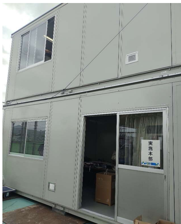
運営用プレハブ (1階：実施本部)
