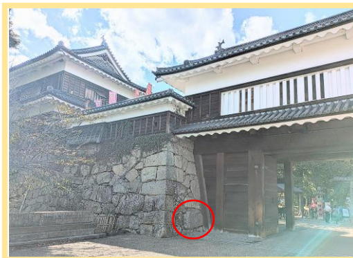
A 南櫓台石垣 櫓門の柱付近
