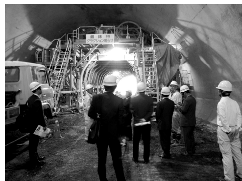
丸子小牧線トンネル工事の現地調査
