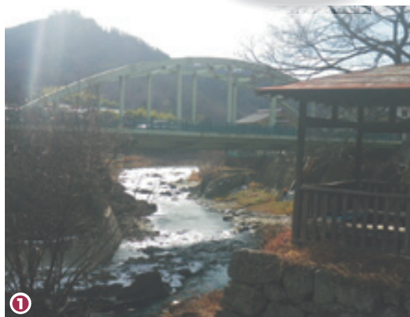
大淵と腰越橋
