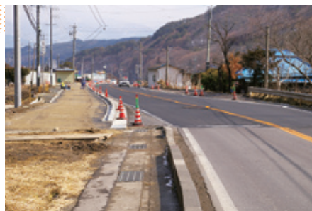
道幅を広げている国道254号
