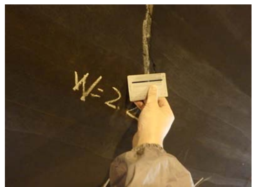
写-2.1.4 クラック幅計測状況
