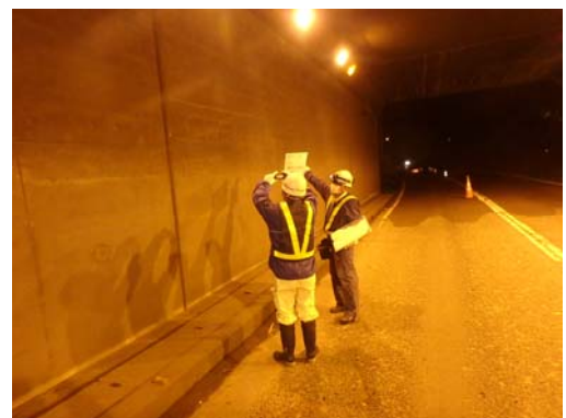
写-2.1.2 側壁部点検状況
