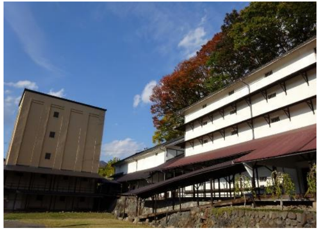
旧常田館製糸場施設 (①五階繭蔵倉庫 他)
