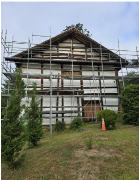
保野塩野神社廻り舞台外壁修理
