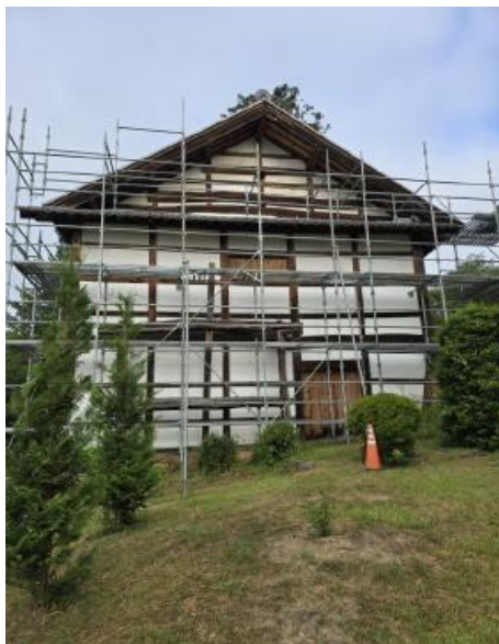
保野塩野神社廻り舞台外壁修理
