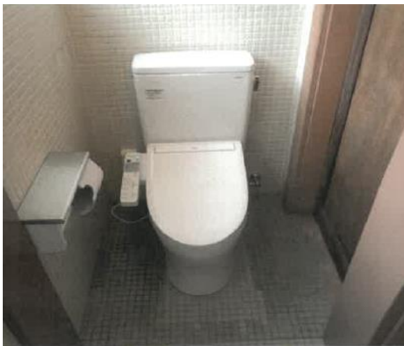
旧千曲会館便所改修
