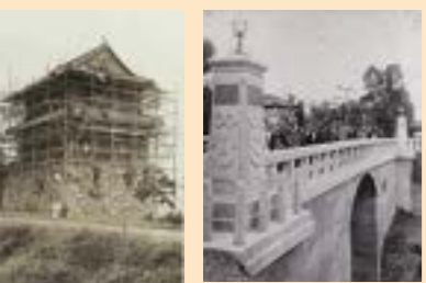
改修中の西櫓(左) 二の丸橋(右)
