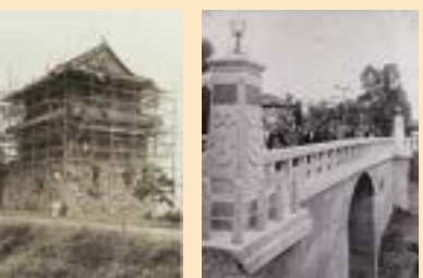
改修中の西櫓 (左) 二の丸橋 (右)
