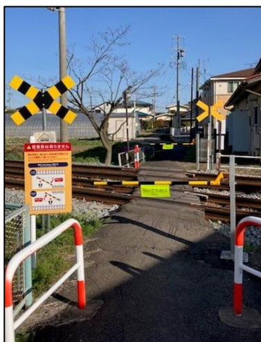
上田～城下間 城下構内踏切
