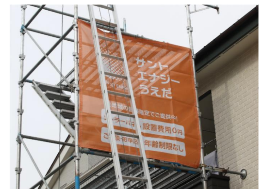
太陽光発電設備施行現場に掲げた仮囲い広告
