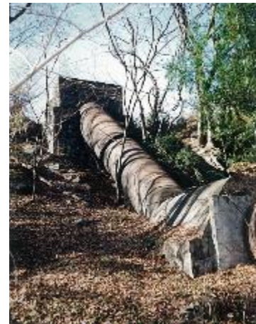
畑山発電所跡
