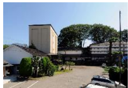
旧常田館製糸場施設
