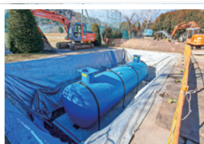
11 耐震性防火水槽設置工事
