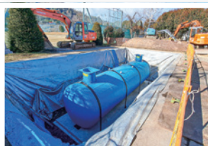
11 耐震性防火水槽設置工事
