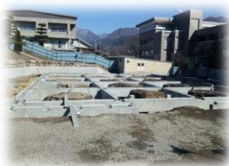
基礎工事(H22.2.23)
