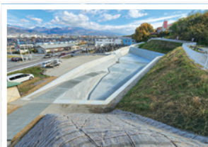
10 御所沢防災調整池
