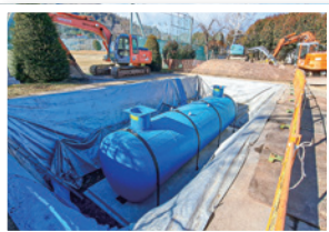
11 耐震性防火水槽設置工事
