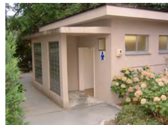
史跡公園内の公衆便所
