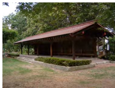
史跡内の構造物：回廊型東屋
