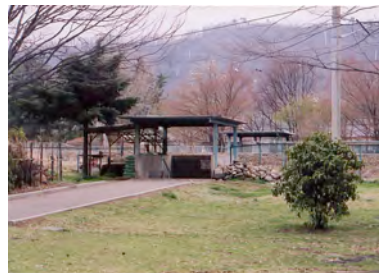
南北連絡地下道入口
