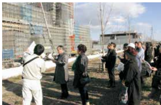
市担当者から建設状況などについて説明
