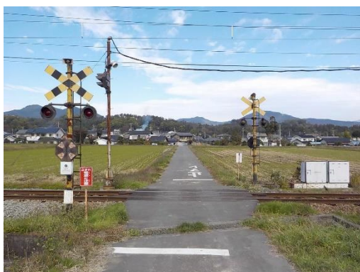
踏切の改良状況（踏切遮断機の設置と、灯火のLED化）
