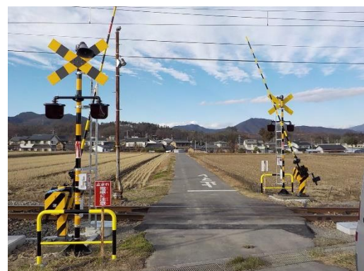
踏切の改良状況（踏切遮断機の設置と、灯火のLED化）
