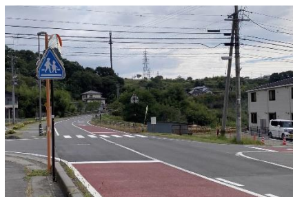
自発光標識とカラー舗装の導入例
