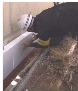
外壁の断熱化工事
