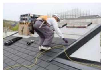
屋根の断熱化工事
