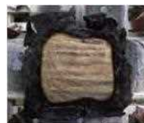
燃焼後の太い柱
